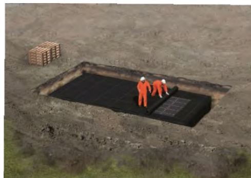
12. ábra: Csomagolás geotextiliával
