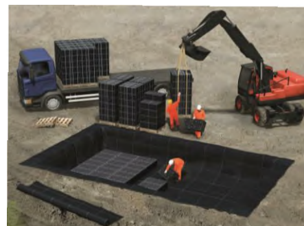
9. ábra: A szikkasztó blokk elemek elhelyezése
