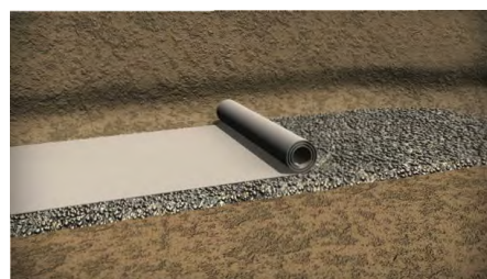
8. ábra: Geotextil lerakása
